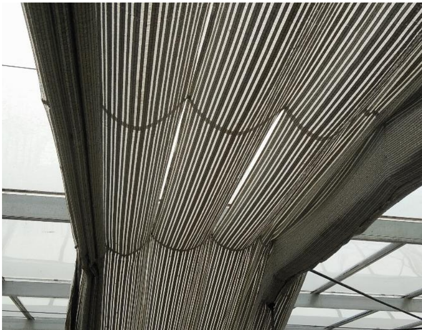
Abb. 1: Schadhafter Energieschirm
