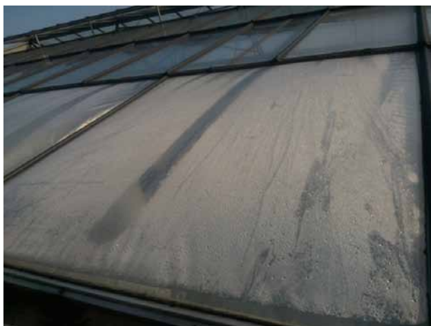
Abb. 1: Bedachungsmaterialien für Gewächshäuser unterscheiden sich deutlich in ihrer Lichtdurchlässigkeit aber auch im Kondensationsverhalten
